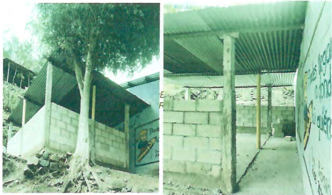
Foto 1: Se prioriza el mejoramiento de techo de estructura metálica tipo portico con láminas troqueladas calibre 26, mejoramiento de pared, ventanas, balcones, piso tipo granito o cerámico y puerta de metal.
